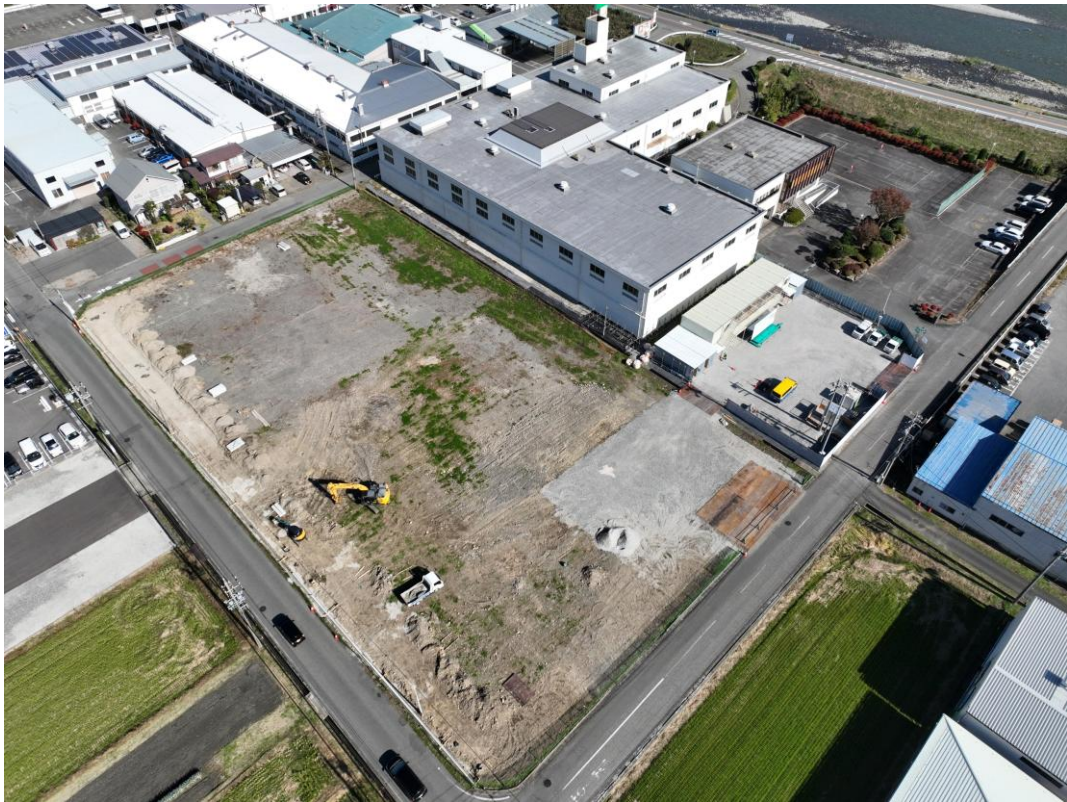
■現場全景 着工時 2024.11.08撮影
