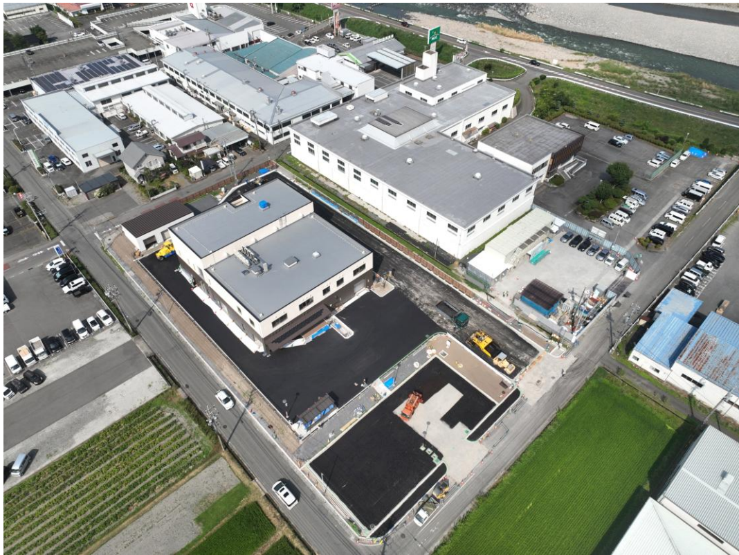
■現場全景 建物完成時 2026.7.31撮影予定
