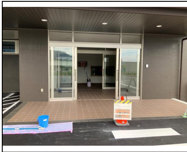
■処理棟1階 正面玄関
