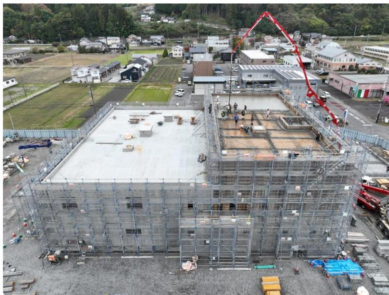
11月5日に無事に最終の躯体コンクリート打設が完了しました。内部地下階では水槽防食工事を実施しています。また12月からは鋼製建具取付工事・屋根防水工事・塗装吹付工事を進め、年明けからはプラント設備工事を開始していきます。地域の皆様には日頃より工事におきまして、大変ご迷惑をお掛けしております。安全に留意して進めて参りますのでご理解、ご協力の程どうぞよろしくお願ひ致します。
